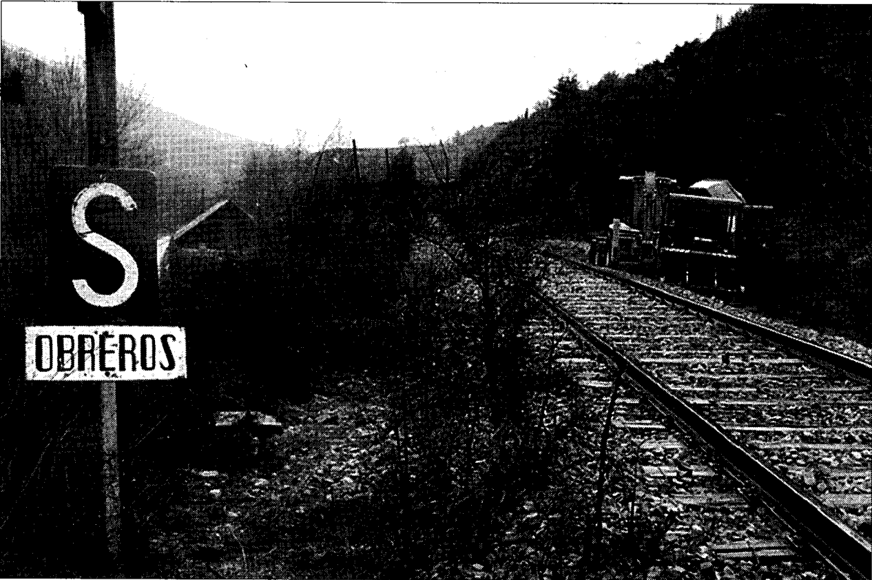
►► Construcción ► Obras de acondicionamiento en uno de los puntos de la vía.
