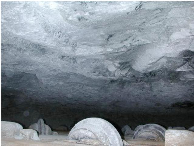
Figure 4 – Formation de blocs devant la tête du tunnelier
