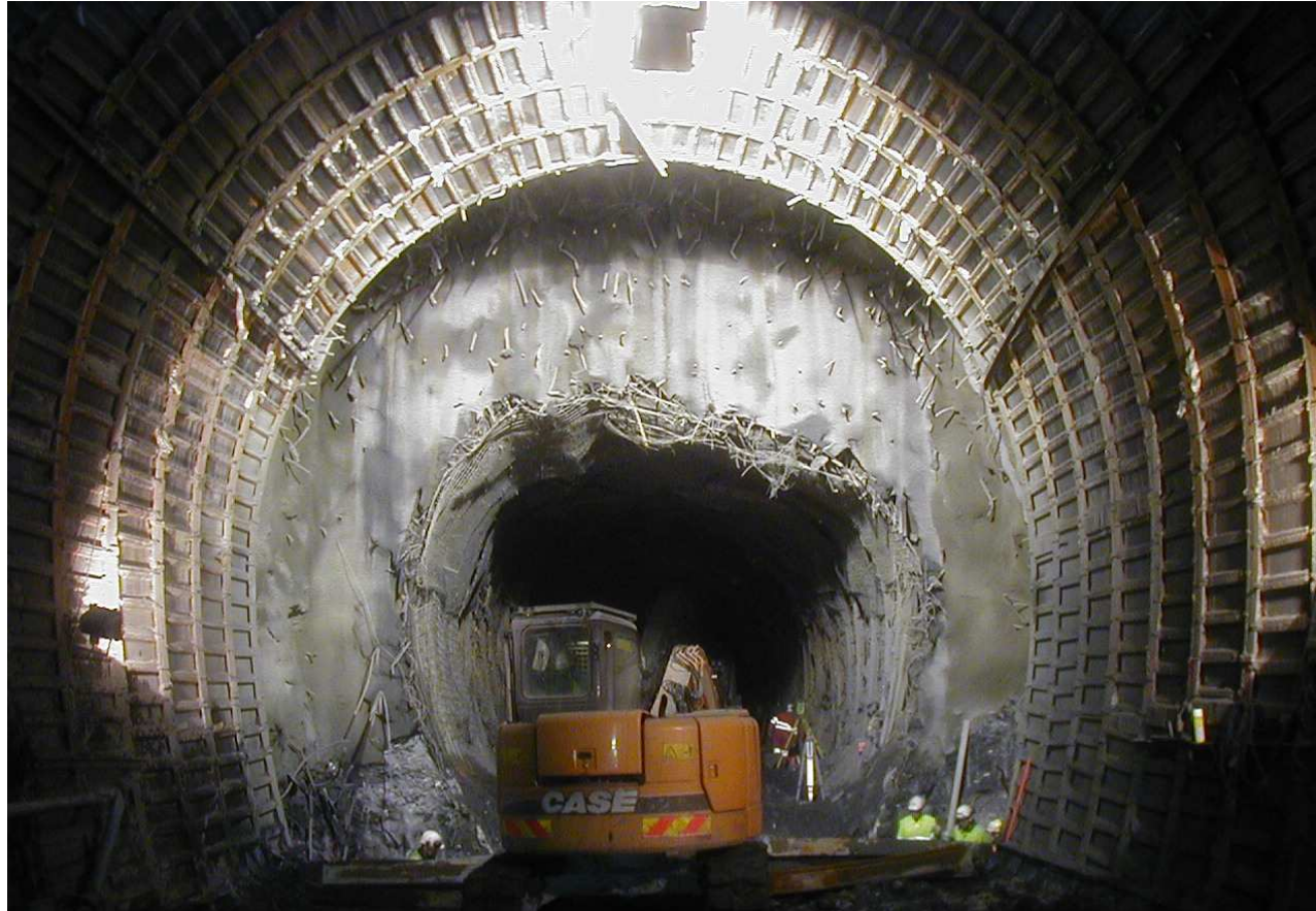
Galerie de reconnaissance de St-Martin-la-Porte (projet Lyon-Turin) Exemple de roches fortement déformables (couverture = 400 m, convergence = 2 m) - Nécessité d'un réalésage
