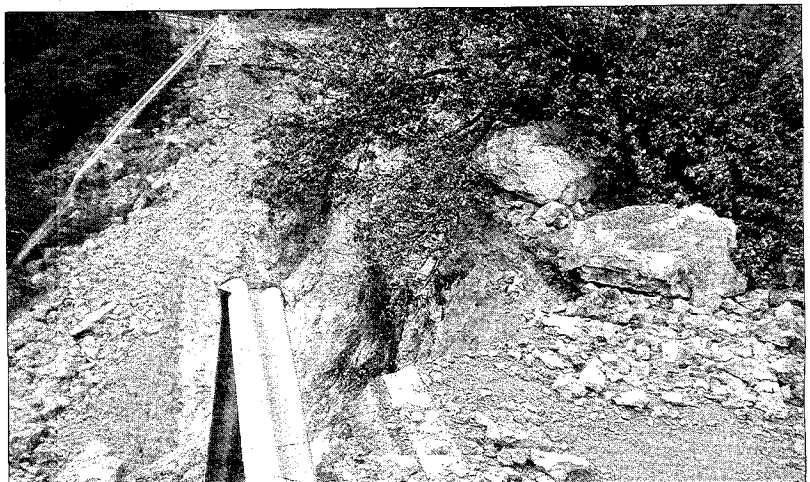
Imagen del estado de la carretera tras el desprendimiento. S.E.
