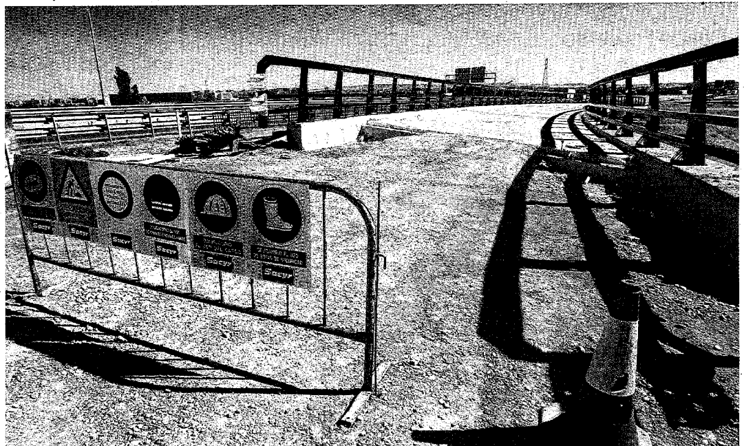
► Las obras de la Ronda Norte, paralizadas en el tramo que se encuentra sobre la autovía de Logroño, la A-68.
