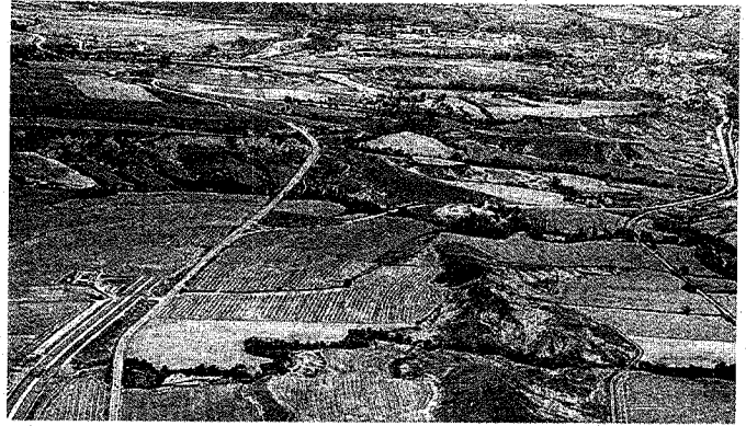
Jaca-Sabiñánigo. El trazado morirá en un erial junto a la actual carretera pese a que los diez kilómetros se están asfaltando para inaugurarlos después del verano. Los cuatro tramos siguientes hasta Lanave están en redacción (1), paralizados (1) o rescindidos (2).
