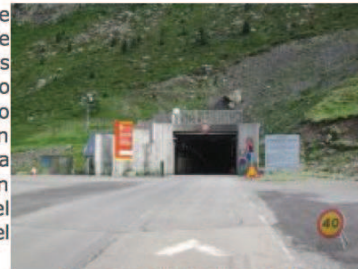
Imagen del túnel de Bielsa
