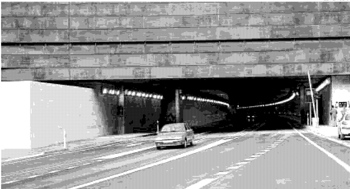
►► Entrada al túnel de Somport en el lado español, en Canfranc.
