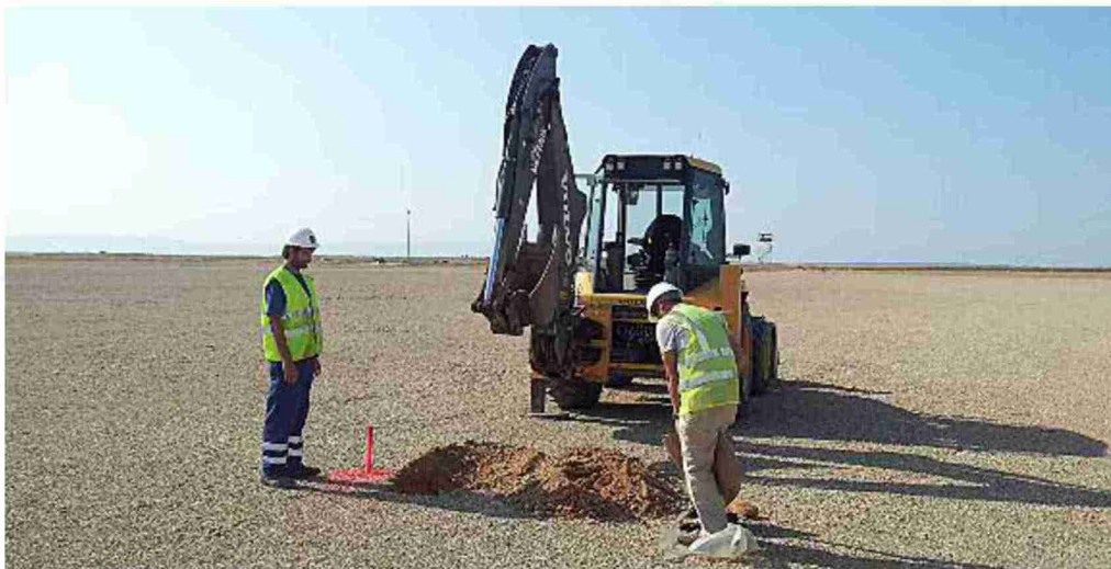
Dos operarios realizan trabajos previos a la pavimentación de la campa del aeropuerto de Teruel para el estacionamiento de aeronaves
