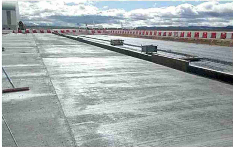
La pavimentación de la plataforma de suministro de combustible para aeronaves, en la foto, se encuentra muy avanzada
