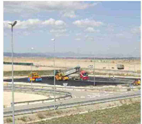
Asfaltado del aparcamiento, hace unos días. Bytafoto / Antonio García
