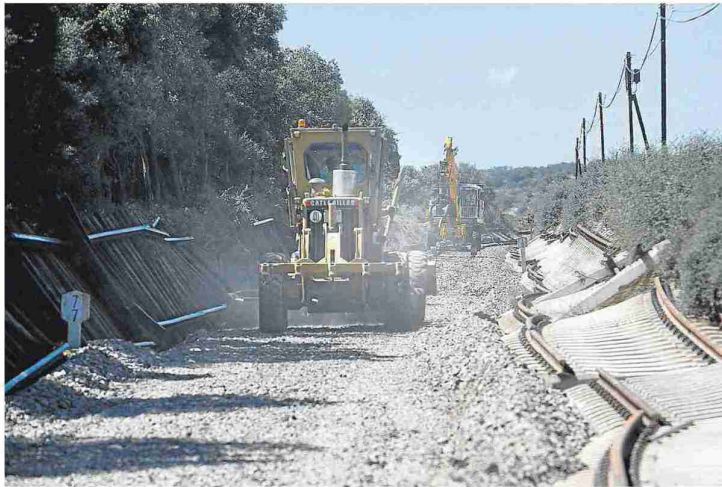
Obras en la línea ferroviaria Huesca-Canfranc a la altura de Alerre, en abril de 2015. JAVIER BROTO
