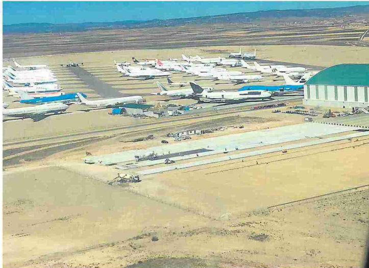
En la foto aérea se aprecian las obras para ampliar la zona de estacionamiento. PLATA
