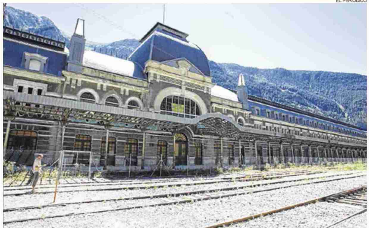
► La estación de Canfranc, en pleno proceso de obras.
