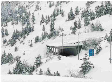
C. TÚNEL BIELSA
