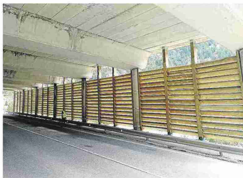
C. TÚNEL BIELSA
