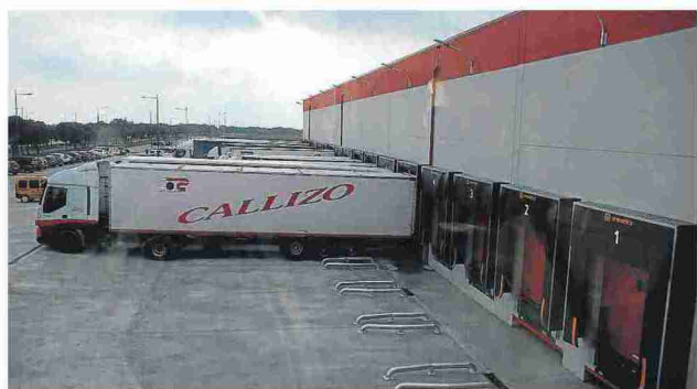
La nave se completa con 8.000 metros cuadrados con 18 atraques para tráiler y otros 22 para vehículos ligeros.
