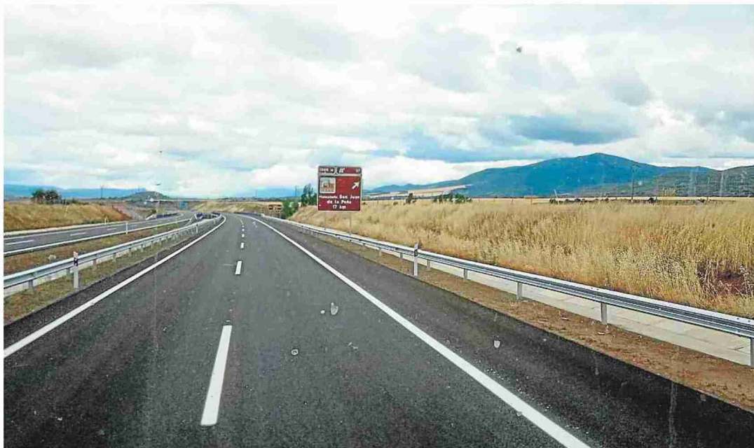
Nuevo tramo de la A-21 que se pondrá hoy en servicio, entre Jaca y Santa Cilia.
