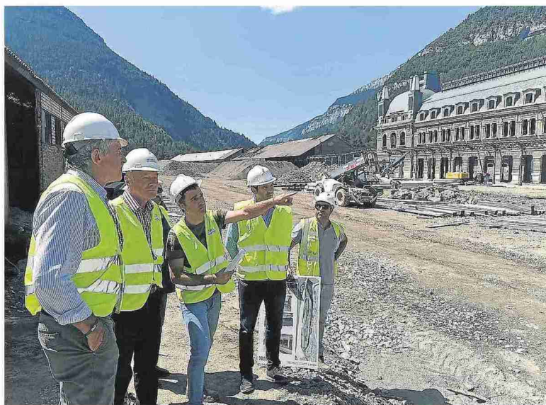
El jefe de obra explica a Alain Rousset –segundo por la izquierda– las obras en la estación. LAURA ZAMBOAÍN
