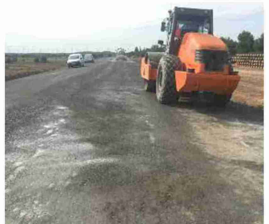
Desarrollo de las obras de mejora en Barracas. Adif
