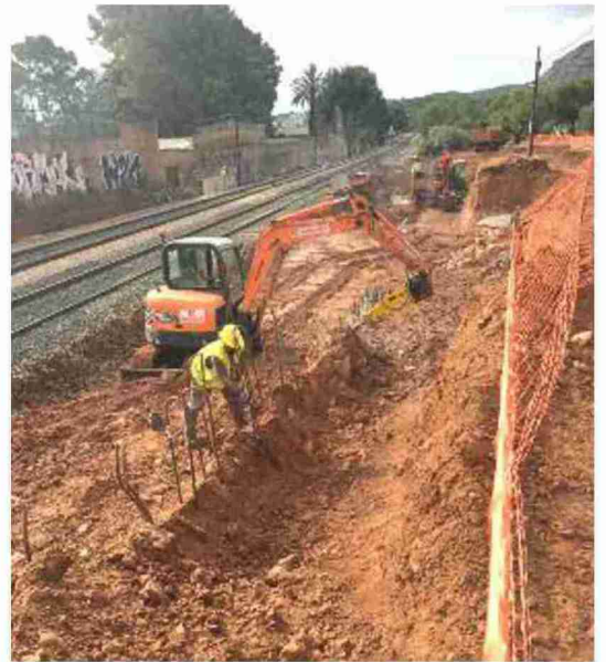
Actuación que se está realizando en Estivella. Adif
