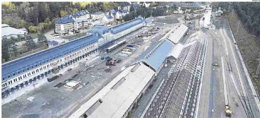
►► Vista de las nuevas vías de la estación de Canfranc.
